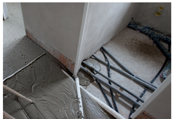
↑ Sichere Einbettung von Rohren, Leitungen und Kanälen.
