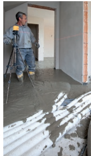
Höhenausgleich und Einbettung → von Versorgungsleitungen.
