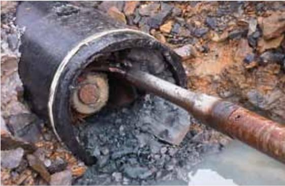
↑ „Einfädeln“ des Spezialbohrkopfes über den Kabelstrang.
