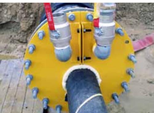
Die Schwierigkeit bei erdverlegten Kabeln besteht in der mit zunehmender Stromlast ansteigenden Leitertemperatur. Bei Kabeln, die in Rohren verlegt sind, kann eine Steigerung der Stromtragfähigkeit – und somit der realisierbaren Übertragungsleistung – durch unser Verfüllmaterial CableCem erreicht werden. CableCem führt durch seinen geringeren thermischen Widerstand die entstehende Wärme wesentlich besser an das umgebende Erdreich ab als bisher verwendete Verfüllbaustoffe.
